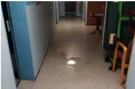
Seit einiger Zeit beobachten wir, dass nach Regenfällen immer wieder Wasser durch die Bodenplatte sickert und für Nichtnutzbarkeit der Kellerräume sorgt. Kontrolle sämtlicher Fall- und Bodenrohre durch ein Fachunternehmen mit Kamera und Rohrfräsen ergab, dass das gesamte Bodenablaufsystem marode, verwurzelt und verstopft ist. Sanierung nach Kostenfeststellung ist für 2019 geplant. Im Moment sind die Abwasserleitungen provisorisch nutzbar.
